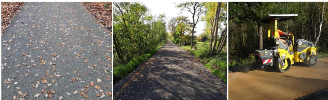
Abbildung 11: Asphaltähnliche Deckschichten aus Gemisch von Basaltstein und Spezialsand / heller Split-Mastix-Asphalt (Quelle: Eigene Aufnahmen)
