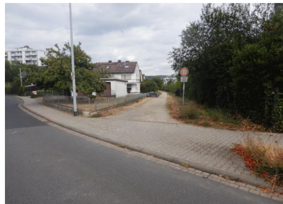
Abbildung 17: Beispiele nicht abgesenkter Bordsteine in Idstein (Quelle: Eigene Fotos)
