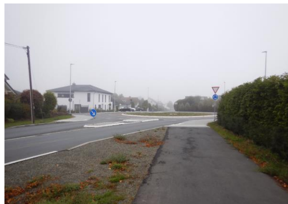
Abbildung 9: Fehlende Überführung auf Radweg am nördlichen Ortseingang Idsteins (links), ungeeignete Überführung auf die Fahrbahn am Kreisverkehr am Ortseingang Walsdorf (rechts) (Quelle: Eigene Aufnahmen)
