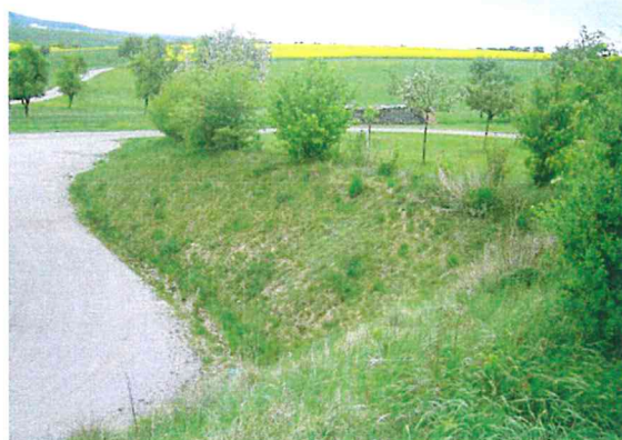
Abb. 5: Blick auf die Böschung mit der Magerraseneinsaat und den Gehölzanzpflanzungen.
