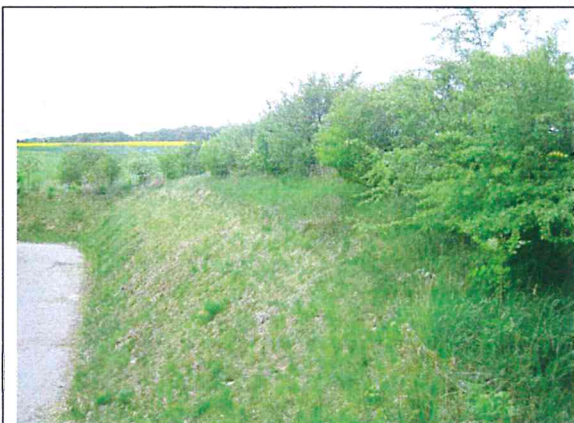
Abb. 4: Blick auf die Böschung mit der Magerraseneinsaat und den Gehölzanzpflanzungen.
