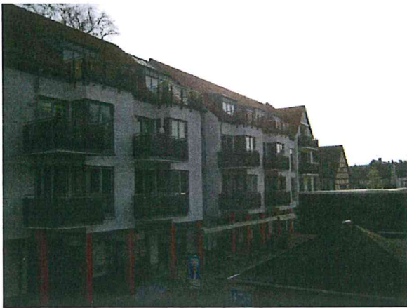
Wohn- und Geschäftshaus Am Hexenturm 1-3
