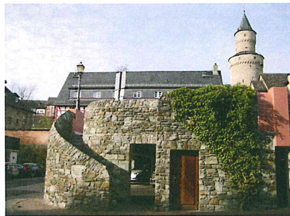
Zugang Parkdeck, rückwärtig Schloßgasse 10
