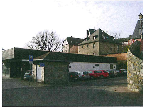
Ehemaliger HL-Markt, rückwärtig Jugendzentrum (Schloßgasse 12 Rückseite)
