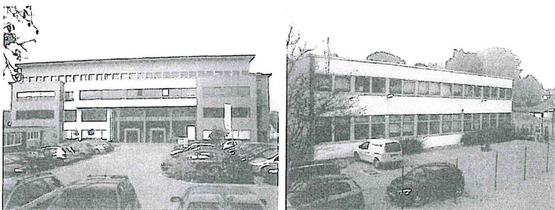
Das neue Hörsaalgebäude der Hochschule
