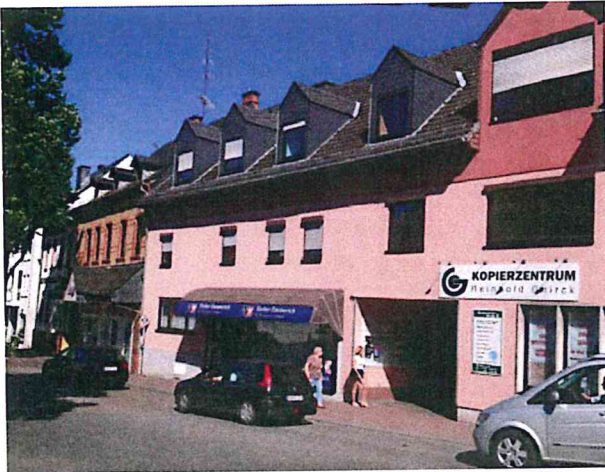
Bild 13 „Bestandsgebäude Wiesbadener Straße“
