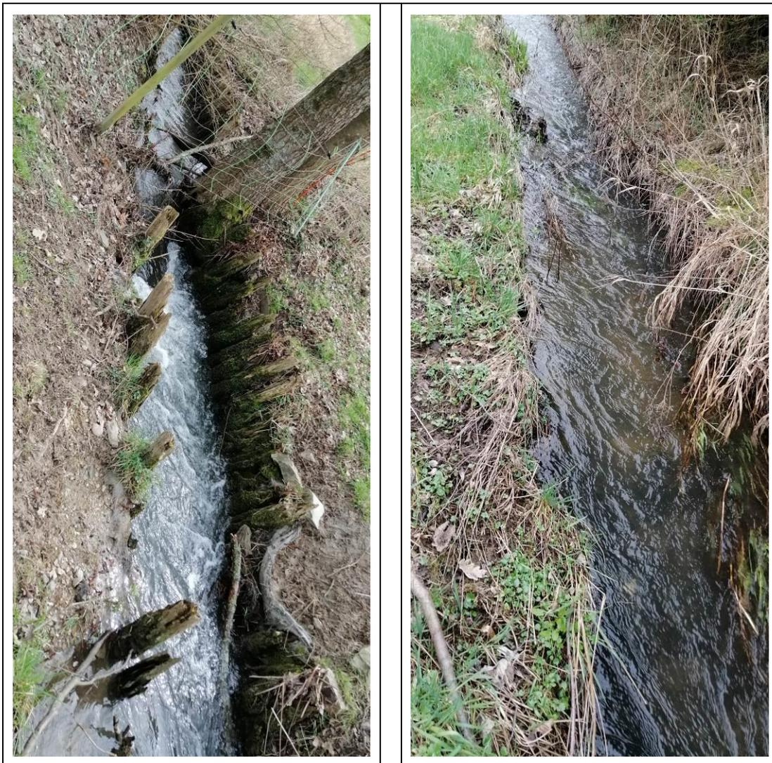
Abbildung 17: begradigte Bachabschnitte mit Holzverbau (links) und Steinsatz (rechts)
