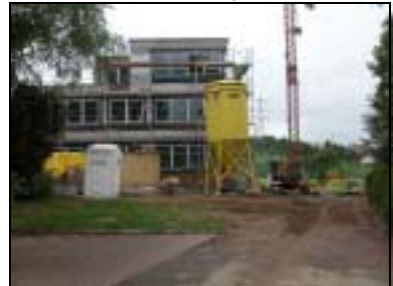
Neubau Auroffer Weg
