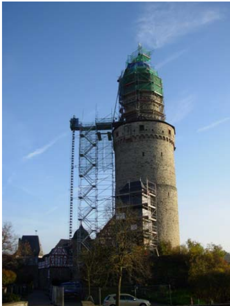
Sanierung des Idsteiner Hexenturmes
