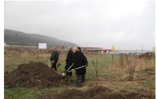
Erster Spatenstich am 9. Dezember 2008 beim neuen Edeka-Markt, Weldertstraße 1, Idstein
