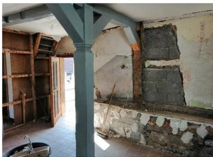
Im Inneren des Erdgeschosses wurden die Holzverkleidung der Wände demontiert und die Wände mit neuem Kalkputz verputzt. Die veraltete Elektroinstallation wurde im Zuge der Sanierungsarbeiten komplett erneuert. Die marode Außentreppe wurde abgerissen und durch eine Neue ersetzt.
