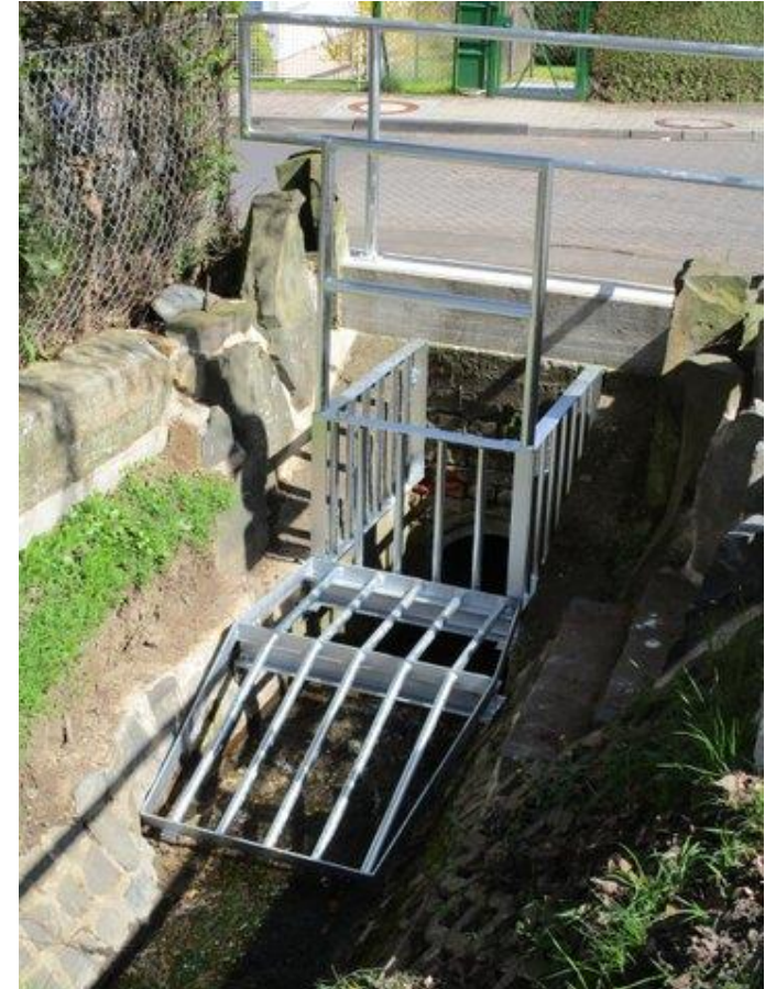
Einlaufrechen nach dem Umbau © Stadt Kassel
