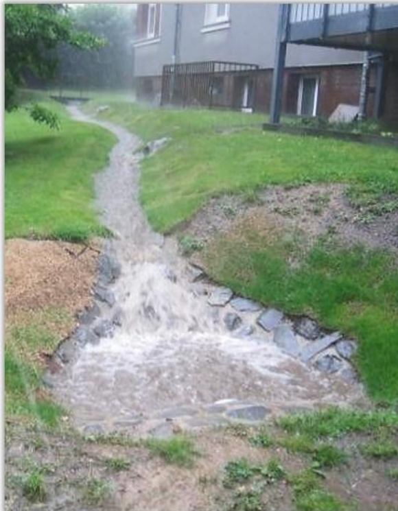
Versickerungsmulde bei Starkregen in Solingen © Kopperschmidt
