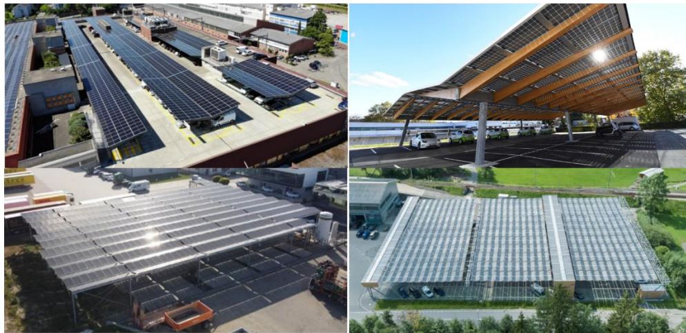
Abbildung 3: Beispielpunkte von Parkplatz-PV-Anlagen in der DACH-Region. Oben links: Solarcarports in München, CH, installierte Leistung: 595 kW p (© Newa One); Oben rechts: Parkplatzüberdachung mit Holzträgern in Lörrach, DE, installierte Leistung: 160 kW p (© Energiedienst AG/ClickCon GmbH); Unten links: Überdachter Mitarbeiterparkplatz in Emdingen am Kaiserstuhl, DE, installierte Leistung: 300 kW p (© focusEnergie GmbH & Co. KG); Unten rechts: Parkplatzüberdachung in Jakobsbad, CH, installierte Leistung: 429 kW p (© dhp-technology)
