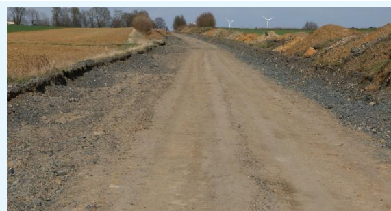
Abschnitt einer ehemaligen Straße nach Entfernung der Asphaltdecke
