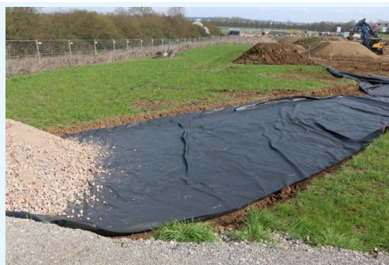
Errichtung einer temporären Baustraße, um Bodenverdichtung durch häufiges Befahren mit Baustellenfahrzeugen vorzubeugen (Quelle: Schnittstelle Boden GmbH)
