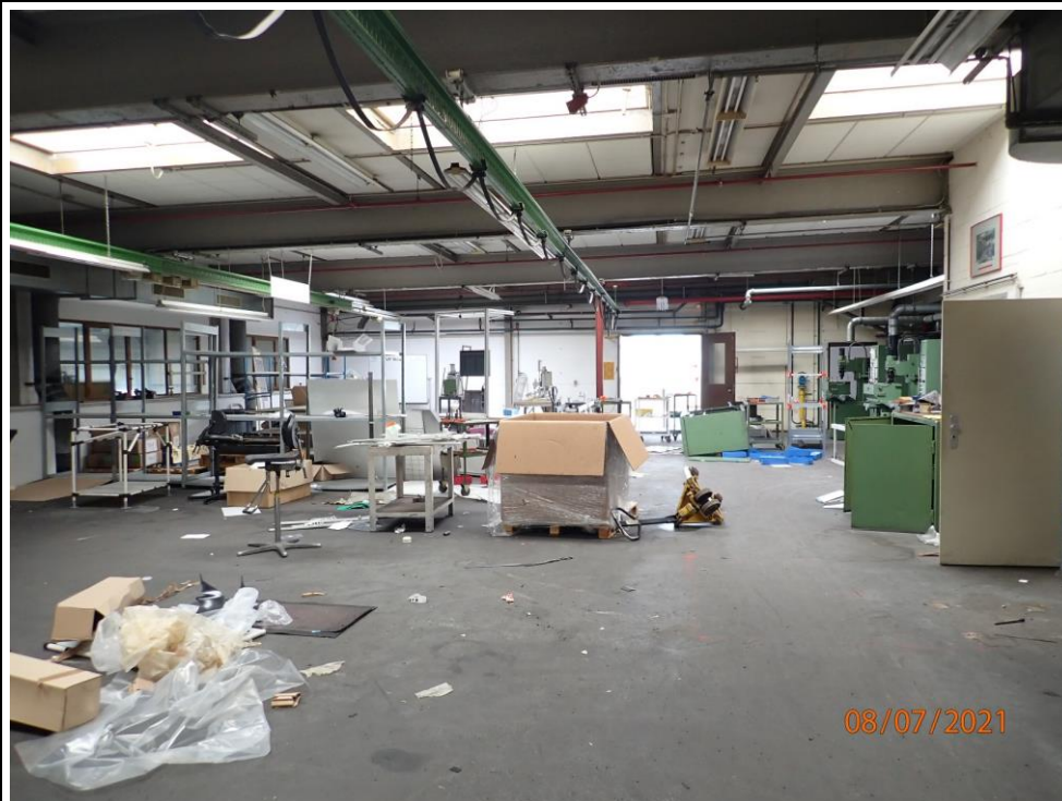
Bild 16: OG Halle 2, Bereich ehemalige Produktion/ Werkzeugbau (Datum: 08.07.2021)
