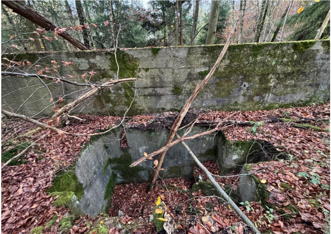
Abbildung 4: Mehrere Betonstrukturen im Bereich könnten Teil der Sprengbunker sein. Im weiteren Verlauf müsste geprüft werden, ob noch Hohlräume vorhanden sind, die Eignung als Fledermausüberwinterungsquartier haben.
