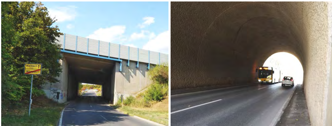
Fotos: für Radfahrer kritische Unterführungen Bahnunterführungen
