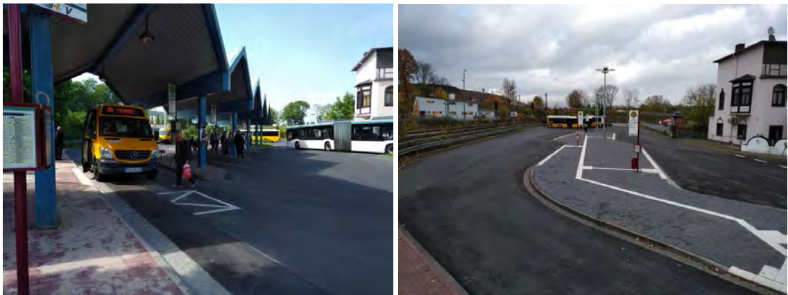
Fotos: Zentralhaltestelle am Bahnhof Idstein vor und nach dem Umbau (2020 neue Überdachung realisiert)
