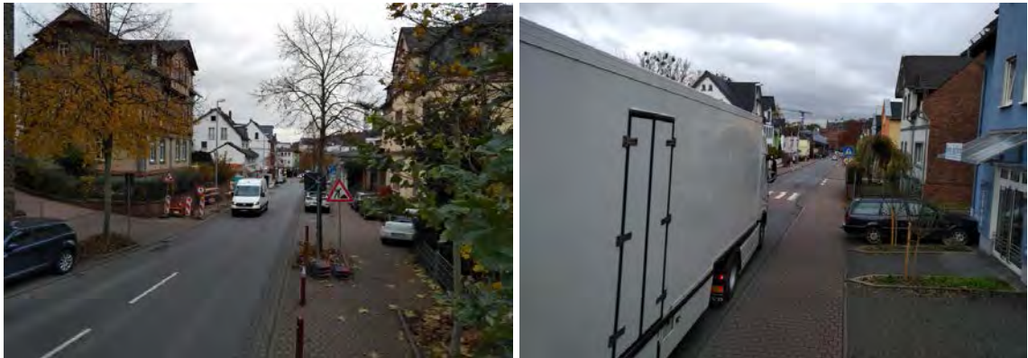
Fotos: Beengte Straßenabschnitte Wiesbadener Straße (ca. 5,50 m) und Limburger Straße (ca. 5,50 m, im Bereich der Gehwegvorstreckung ca. 4,75 m, 2020 im Rahmen der Deckenerneuerung rückgebaut)
