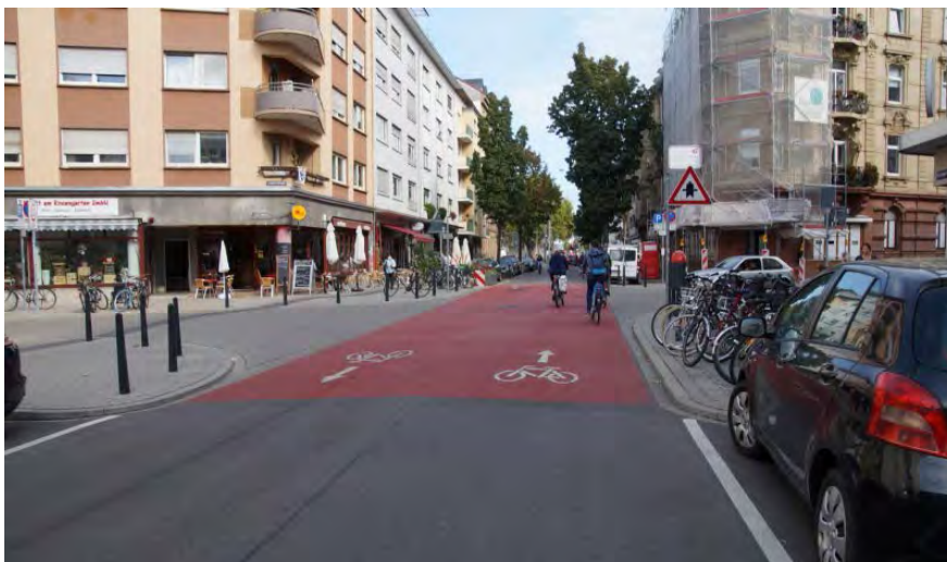
Foto: Beispiel für die Gestaltung eines Knotenpunktes innerhalb einer Fahrradstraße (Mannheim)
