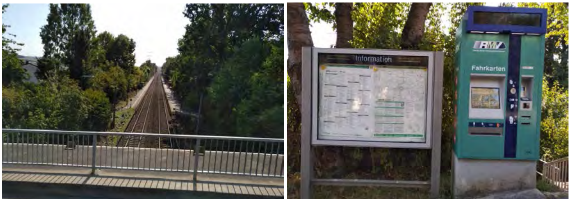
Fotos: Blick auf die Bahnsteiganlagen, Ausstattung mit Informationstafel und Fahrscheinautomat
