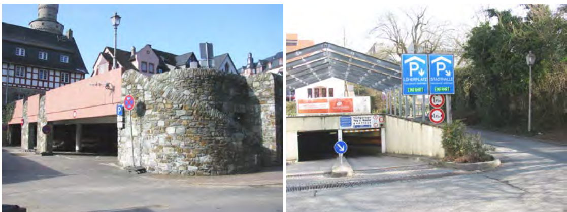
Fotos: Tiefgaragen Stadthalle und Löherstraße, Parkdeck Am Hexenturm
